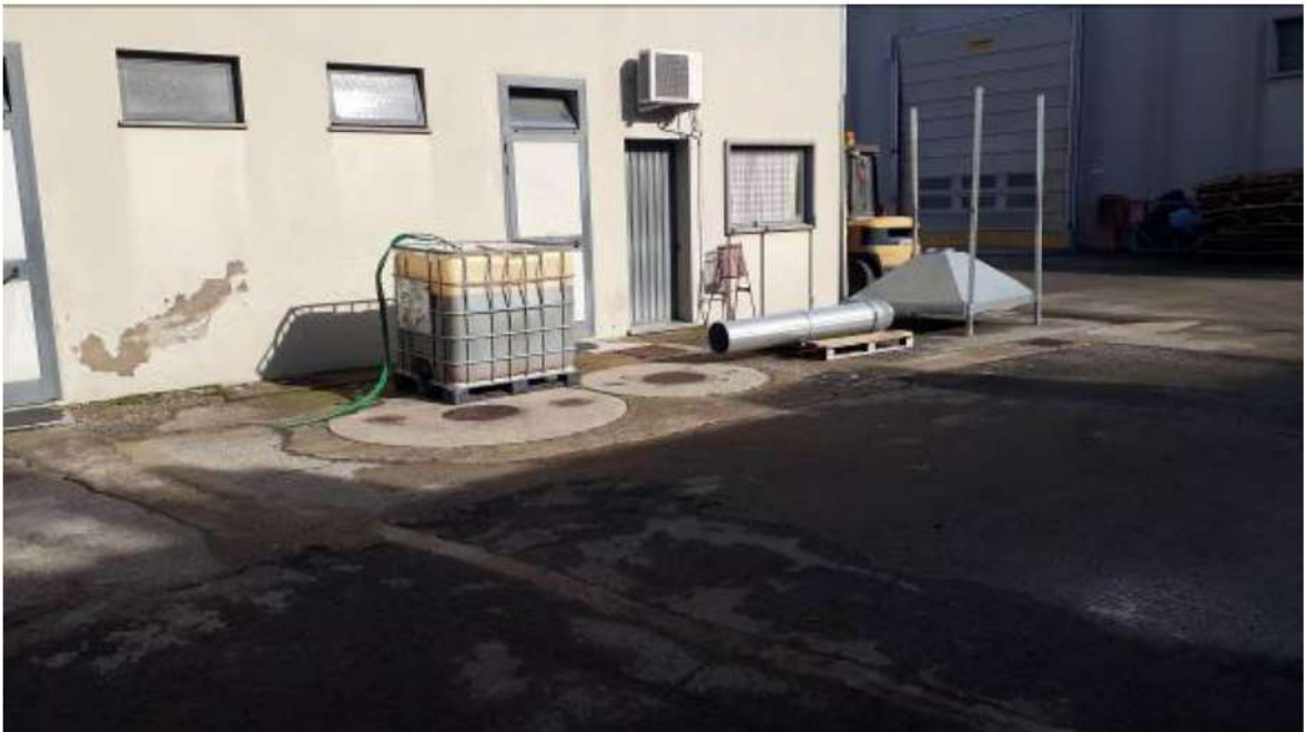
Cisterna di gasolio per alimentare la caldaia (tubazioni di alimentazione poste sotto traccia a terra)
